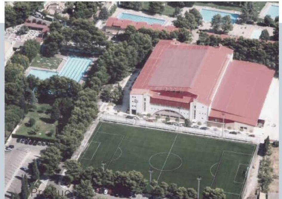
Vista panorámica de las instalaciones
